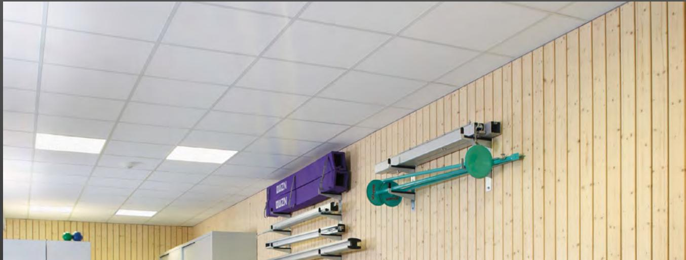
SICHTBAR, HERAUSNEHMBAR, BALLWURFSICHER – 24 MM BREITE PROFILE
