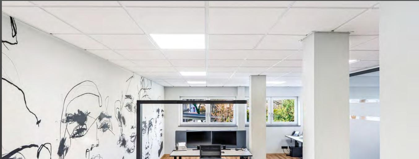
SICHTBAR, HERAUSNEHMBAR – 24 MM BREITE PROFILE – CONTURA
