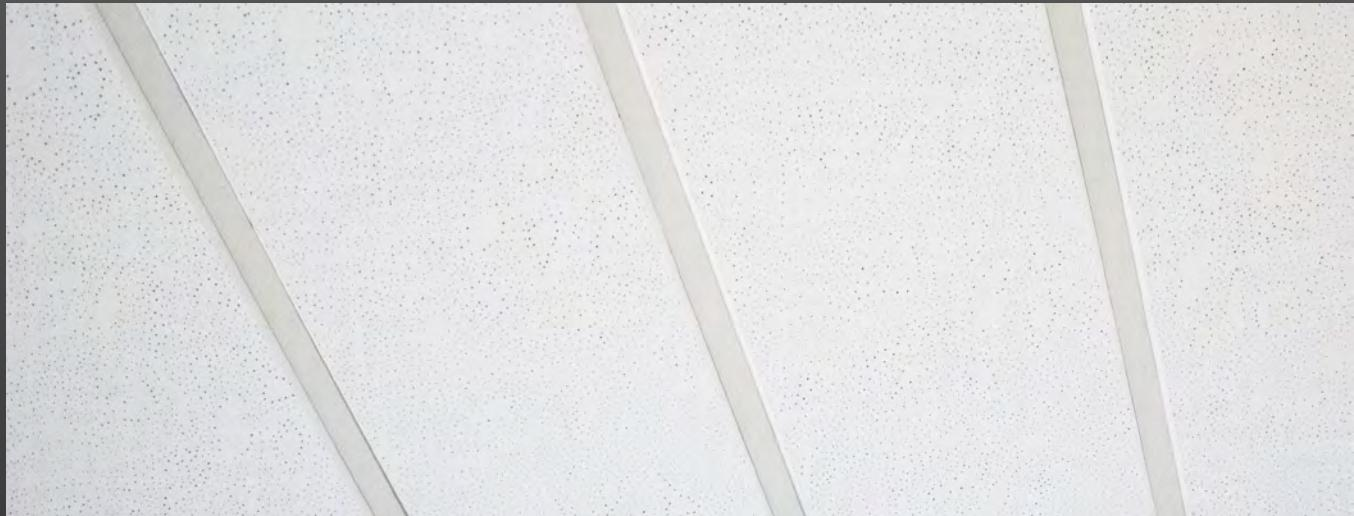
FREIGESPANNT – SICHTBAR, HERAUSNEHMBAR – 24 MM BREITE PROFILE –
