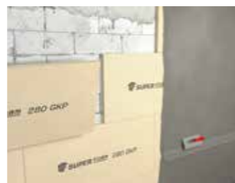
Als Wärmebrückendämmung und im Innenausbau
