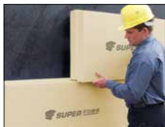
Perimeterdämmung an Kelleraußenwänden
