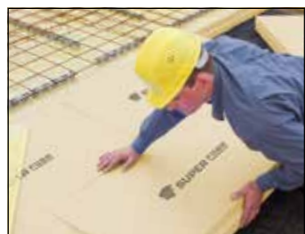
Perimeterdämmung unter lastabtragenden Bodenplatten
