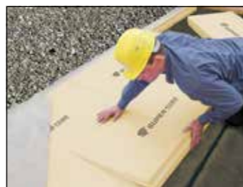
Neubau und Sanierung von Flach- und Umkehrdächern
