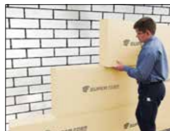
Als Wärmebrückendämmung und im Innenausbau
