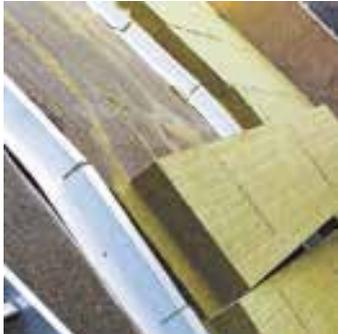
Das Shedrock-Dämmsystem eignet sich für die energetische Sanierung von Sheddächern mit ebenen oder gekrümmten Betontragschalen. Es umfasst folgende Systemkomponenten:
