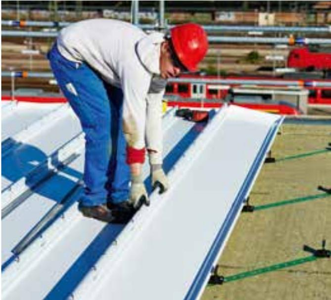
Das Prodach-Dämmssystem ist eine nahezu wärmebrückenfreie Distanzkonstruktion für das nicht belüftete Metалldach. Das System umfasst folgende Komponenten:
