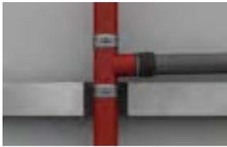
Fertig installierte Abwasserleitung mit Kunststoff-Übergangsverbinder.
