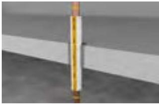
Rohr blank z. B. Gasleitung ohne Weiterdämmung
