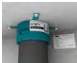
Anschrauben und Rohrabschottung mit Kennzeichnungsschild kennzeichnen.
