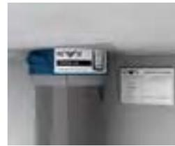
Abschließend Rohrabschottung mit Kennzeichnungsschild kennzeichnen.
