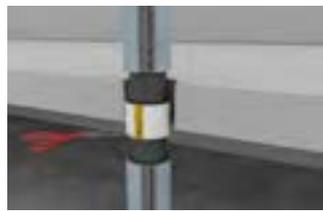
Montagevorbereitung für weiterführende Schall- und Schweißwasserdämmung: Kürzung der Überstände der BSM-KR
