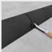
Ca. 10 mm länger zuschneiden: Druckverarbeitung gewährleisten.
