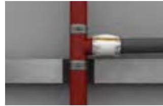
Klettverschluss an BSM-GuKu verschließen. **Beachte: Spanschelle muss auf Gussrohr positioniert sein.**
