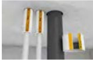
**Anlegen der BSM-KR:** Öffnen und um das Rohr legen.
