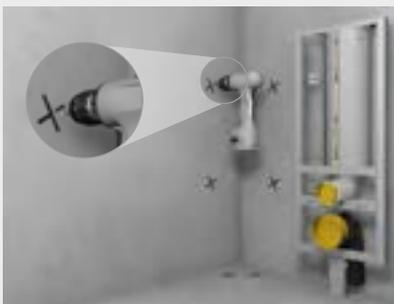
Missel Kompakt-Spülrohr mit Mittelfuß positionieren, Montagehöhe einstellen, Bohrlöcher markieren und bohren.
