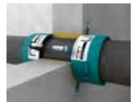
UNIFOX: Bei einer Fugenbreite von ≤ 15 mm dürfen die Fugen mit Mineralwolle (Schmelzpunkt ≥ 1.000° C) fest ausgestopft werden.
