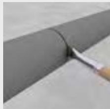
Ca. 10 mm länger zuschneiden: Druckverarbeitung gewährleisten.
