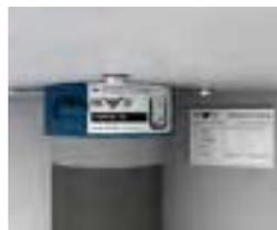
Anschrauben und Rohrabschottung mit Kennzeichnungsschild kennzeichnen.
