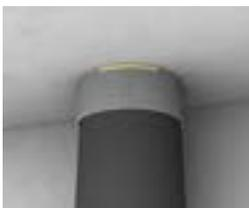
Rohr isolieren und Öffnung mit Mörtel verschließen.
