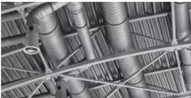
Bestehen bei Lüftungsleitungen Temperaturunterschiede, steigt das Risiko für Tauwasserbildung. Besondere Priorität im Bereich Klima liegt daher auf einem exzellenten Wasserdampf-Diffusionswiderstand.
