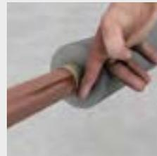
Schnell-Check: Fingerrückenprobe anwenden.
