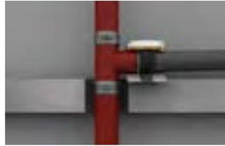
BSM-GuKu Manschette oberhalb des Kunststoff-Übergangsverbinder (Konfix) positionieren. **Beachte: Klettverschluss oben**
