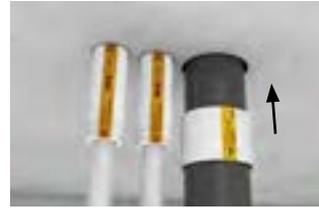
**Platzierung der BSM-KR:** BSM-KR schließen und bis zur Markierung ins Bauteil schieben.
