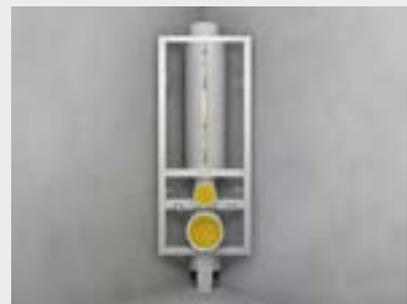
Abwasserbogen dämmen, Gewindestangen für WC-Befestigungen montieren.
