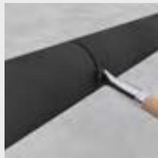
Ca. 10 mm länger zuschneiden: Druckverarbeitung gewährleisten.
