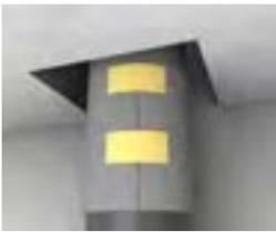
Schaumstreifen mit Klebestreifen um das Rohr befestigen.
