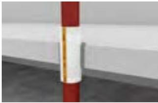
Rohr blank z. B. Gussleitung ohne Weiterdämmung
