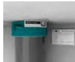
Abschließend Rohrabschottung mit Kennzeichnungsschild kennzeichnen.
