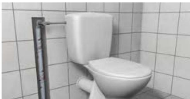
Sanierung: Die WC-Zuleitungen im Bestand vor Schwitzwasser, Wärme- und Körperschallübertragung schützen.
