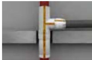
Verbinder-Manschette über dem Rapidverbinder montieren und Klettverschluss verschließen.
