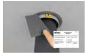
Brandsicherer Verschluss und Kennzeichnung.
