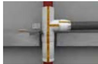
Deckenverguss herstellen, Kennzeichnungsschild anbringen.
