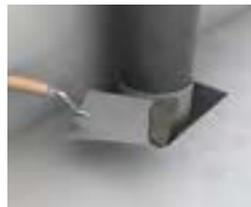
Restöffnung in Bauteildicke mit mineralischem Mörtel verschließen.
