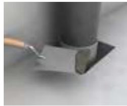
Restöffnung in Bauteildicke mit mineralischem Mörtel verschließen.
