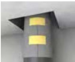
Schaumstreifen mit Klebestreifen um das Rohr befestigen.
