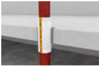
Rohr blank z. B. Gussleitung ohne Weiterdämmung
