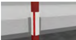
Regenwasser- und Feuerlöschleitungen aus Guss/Stahl
