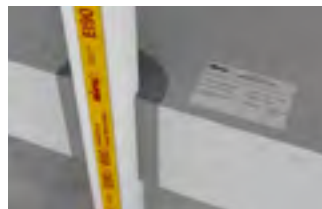
Die Ringspaltbreite darf 5 mm bis 30 mm betragen.
