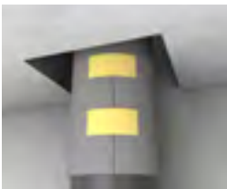
Schaumstreifen mit Klebestreifen um das Rohr befestigen.
