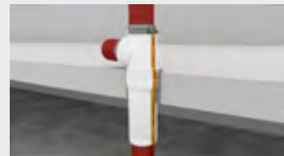
Montage in Massivdecke mit Formteilen, z. B. mit Abzweig
