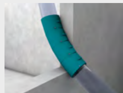
Einbau weiterer Manschetten in Schachtelbauweise.
