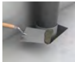
Restöffnung in Bauteildicke mit mineralischem Mörtel verschließen.
