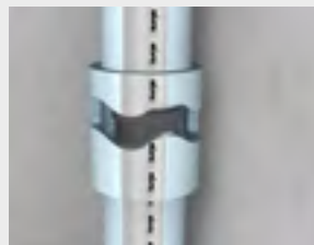
Überdämmung Muffe mit Formteil.
