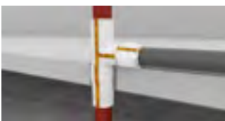
Seitlicher Übergang Guss-Kunststoff-Abwasserleitungen
