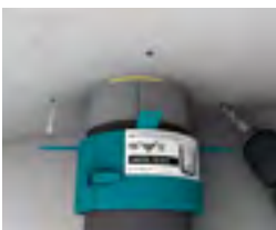
Dübellöcher bohren und Dübel setzen.
