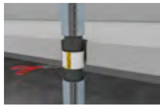
Montagevorbereitung für weiterführende Schall- und Schwitzwasserdämmung: Kürzung der Überstände der BSM-KR
