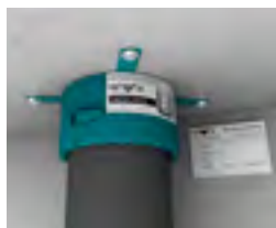
Anschrauben und Rohrabschottung mit Kennzeichnungsschild kennzeichnen.
