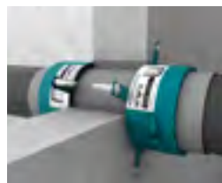
Wandmontage: Im Gegensatz zur Decke müssen bei Wanddurchführungen zwei Brandschutzmanschetten angeordnet werden.
