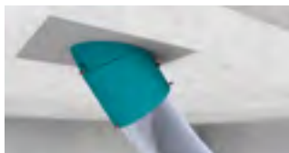
PVC-U-Rohrbögen von Rohrpostanlagen
