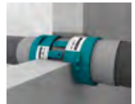
Wandmontage: Im Gegensatz zur Decke müssen bei Wanddurchführungen zwei Brandschutzmanschetten angeordnet werden.
