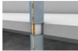
Überdämmung außerhalb der Decke
