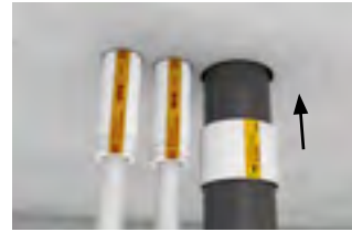
Platzierung der BSM-KR: BSM-KR schließen und bis zur Markierung ins Bauteil schieben.
