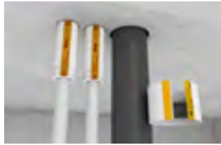
Anlegen der BSM-KR: Öffnen und um das Rohr legen.
