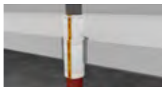
Senkrechter Übergang Guss-Kunststoff-Abwasserleitungen
