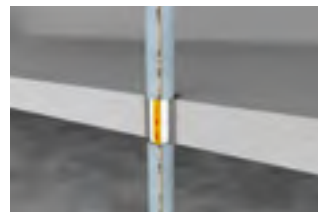
Überdämmung außerhalb des Bauteils (Wand bzw. Decke) möglich
