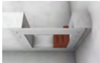
Aufleistung für Massivdecke
