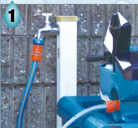
Wasserzufuhr von einem Hauswasseranschluss
