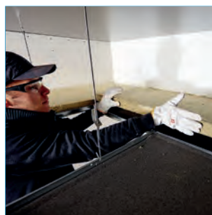
RAF Schallschluckplatte Euroklasse A1, Wärmeleitfähigkeit \lambda = 0,040 W/(m·K)
